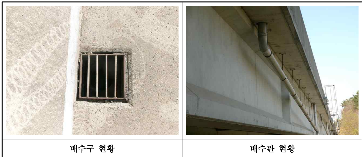
【사진 6.3.22】 배수시설 전경
