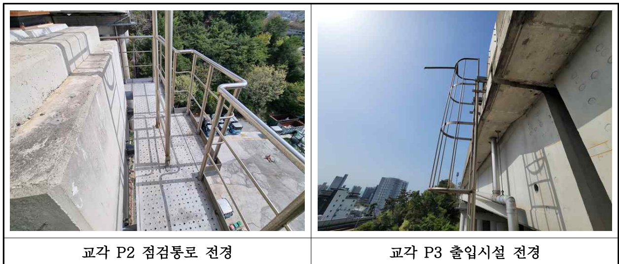
【사진 6.3.26】 교량 점검시설 전경
