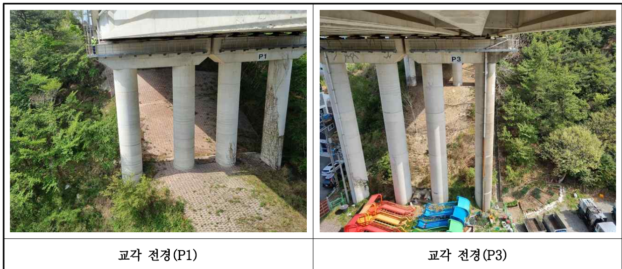
【사진 6.3.10】 교각 전경
