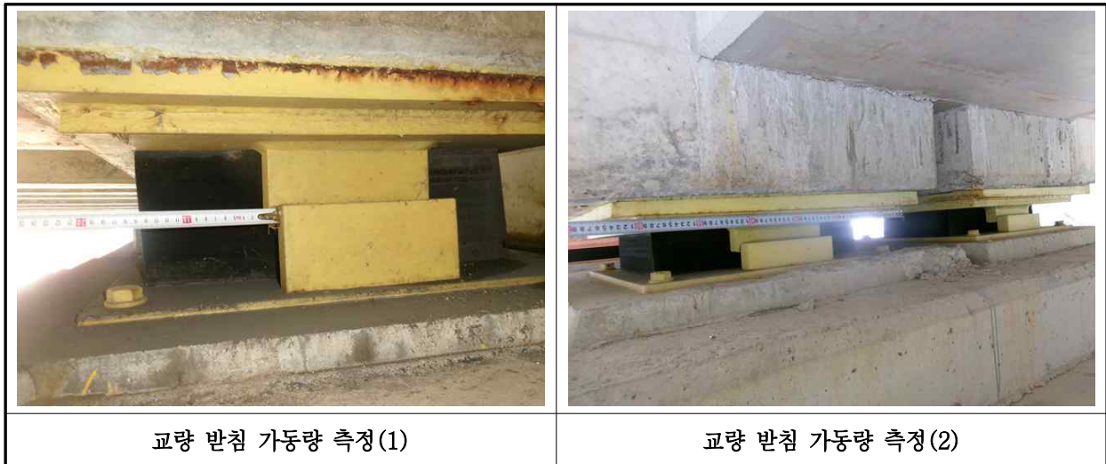
【사진 6.3.16】 교량받침 이동량 측정
