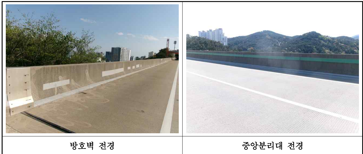
【사진 6.3.24】 방호벽 및 중분대 전경
