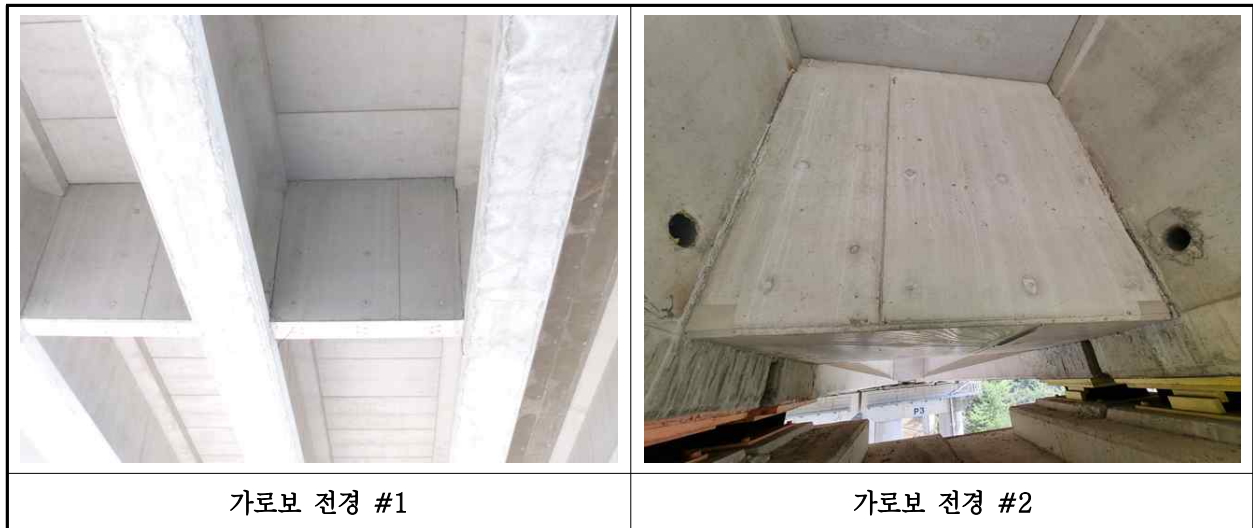
【사진 6.3.6】 가로보 전경
