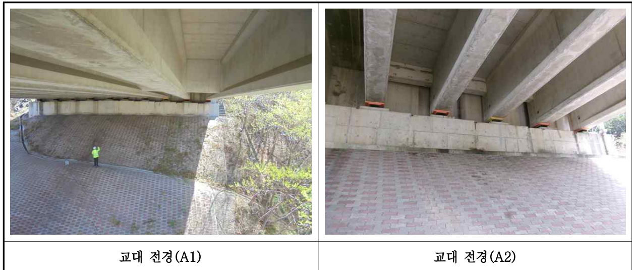
【사진 6.3.8】 교대 전경
