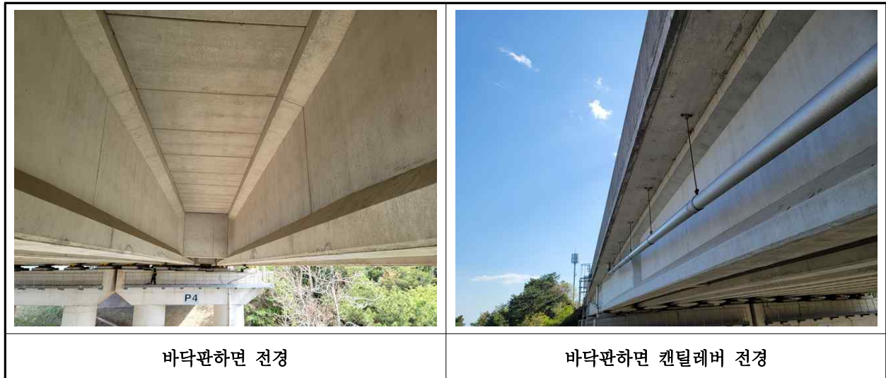
【사진 6.3.2】 바닥판하면 전경
