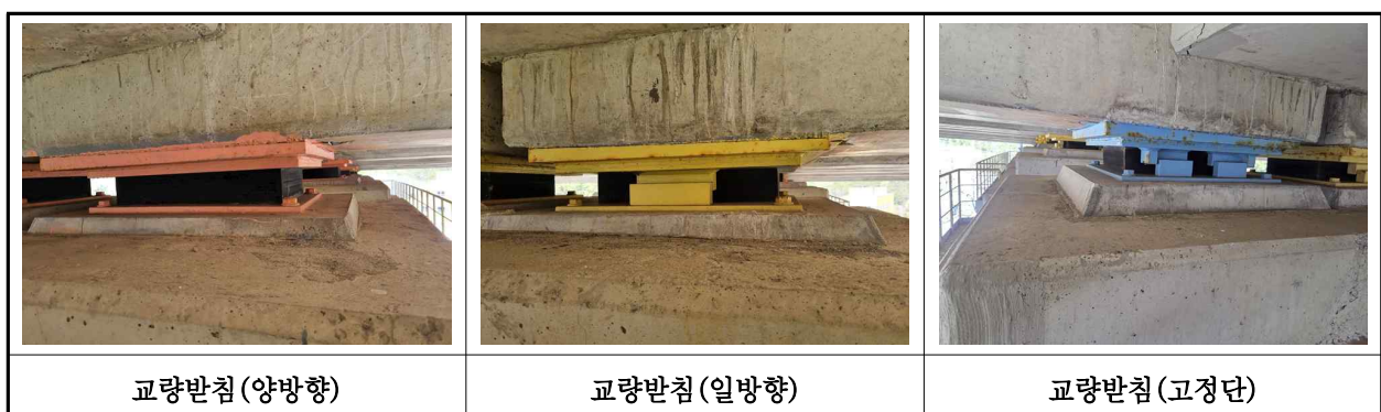
【사진 6.3.13】 교량받침 전경
