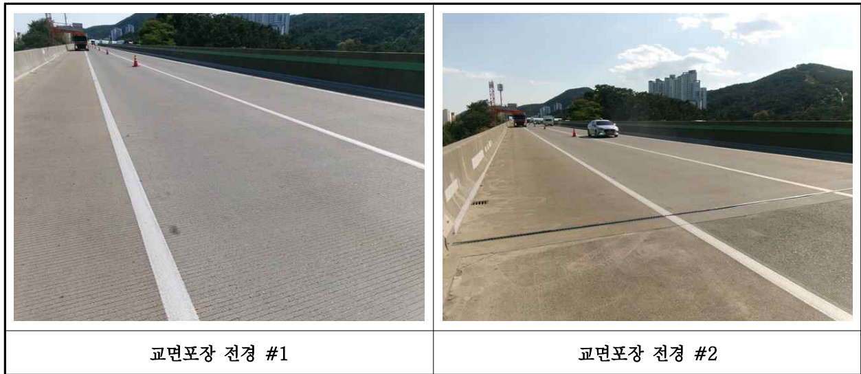
【사진 6.3.20】 교면포장 전경
