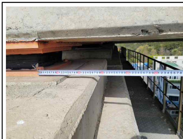
받침장치 연단거리 측정 #1
