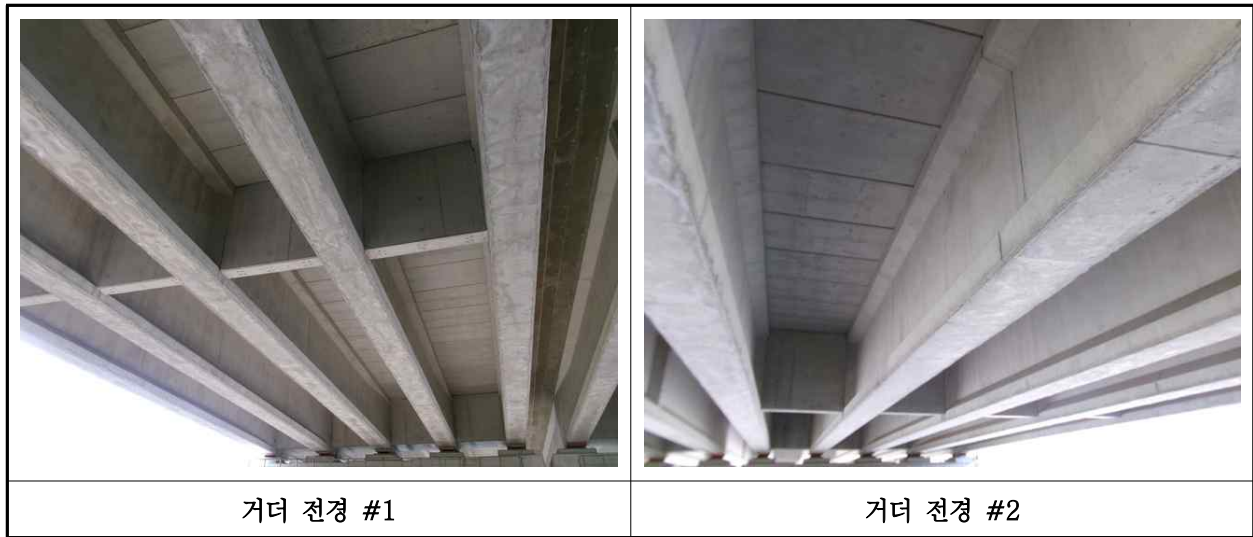
【사진 6.3.4】 거더 전경
